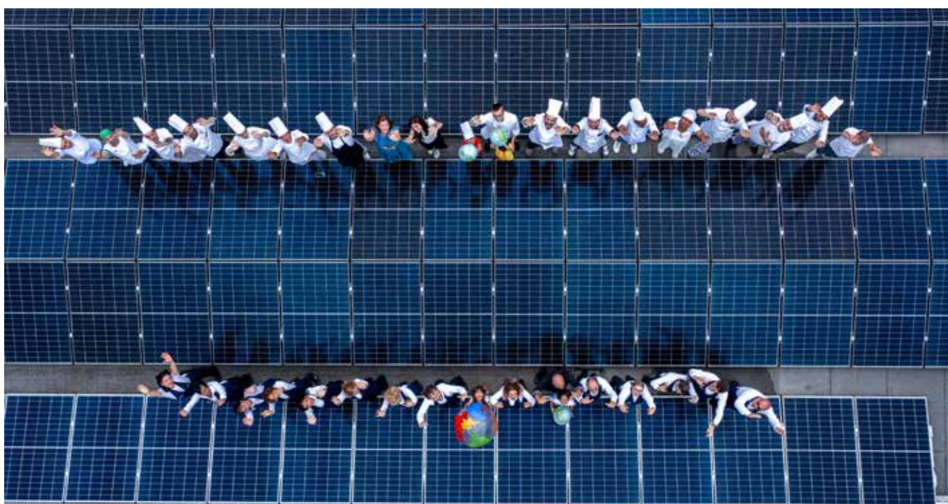
Nella foto, un dettaglio dell'impianto fotovoltaico installato sul tetto del nostro ristorante "Aglie e Oglio" di Rogno (Bg)
